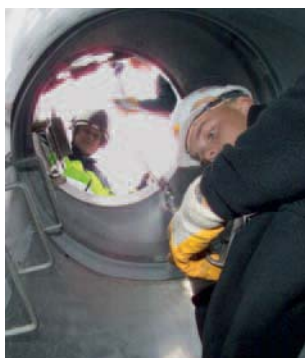
Beaufsichtigung der Arbeiten in engen Räumen
