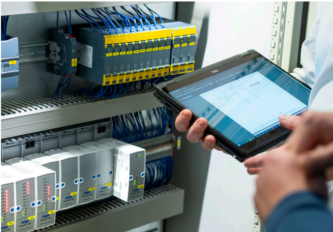
Die Ansaugereinheiten übermitteln ihre Signale an die Auswerteeinheit REGARD 7000.
