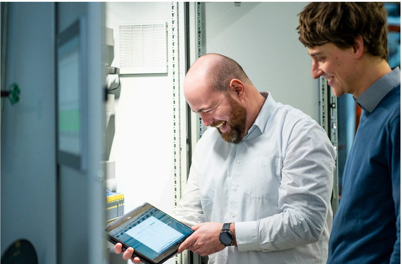
Vertriebsingenieur Christian Pamer und Raphael Winter, Leiter des Wärmepumpenlabors und Prototypenbaus, vor dem REGARD® 7000 Schaltschrank.
