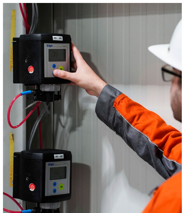
Die Transmitter Dräger Polytron® 7000 mit integrierter Pumpe sind durch die Montage an der Hallenwand gut erreichbar.
