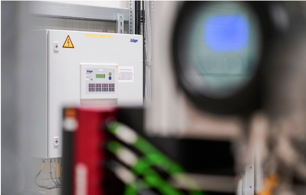
Die Auswerteeinheit Dräger REGARD® 3910 verarbeitet die eingehenden Signale der Messköpfe und leitet bei Bedarf Maßnahmen ein.
