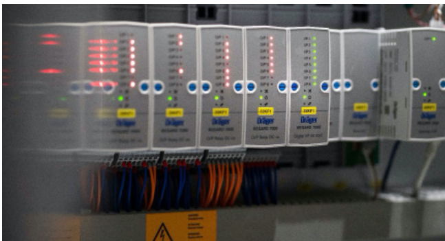
Der Schaltschrank wurde von Dräger entwickelt und ist das Herz der Gaswarnanlage.
