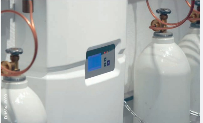
Les paramètres opérationnels de la GCS sont affichés au centre du module de contrôle.
