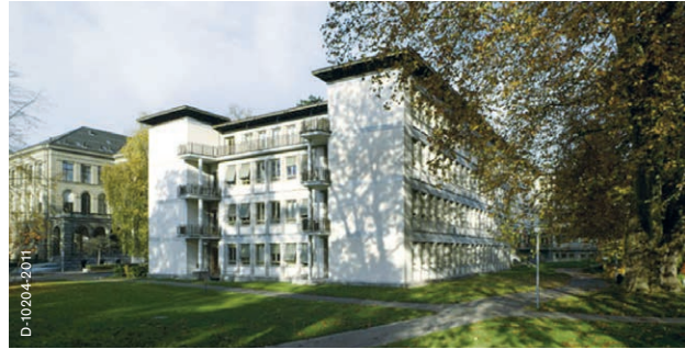
Hospital Universitario de Zürich
