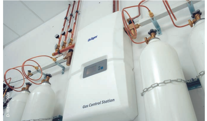
Het aantal aangesloten gascilinders en de tankinhoud voor vloeibaar gas kunnen individueel in geprogrammeerd worden.
