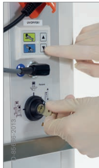
Panel de control de la unidad de suministro de techo con interruptores con llave
